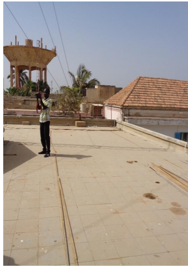
Rathausdach für die PV-Anlage ©Stadt Rastatt
